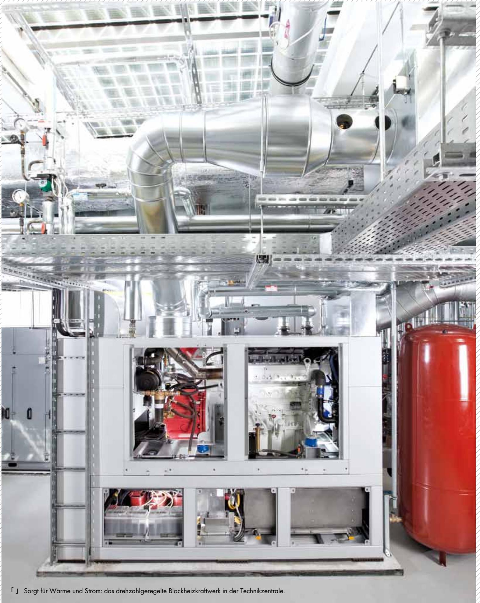
「 」 Sorgt für Wärme und Strom: das drehzahleregelte Blockheizkraftwerk in der Technikzentrale.
